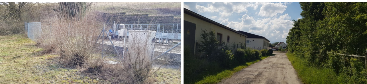
Abb. 9: Heckenpflanzung als Begrenzung des Kläranlagengeländes zum Weg an den Grabenwaldsee
